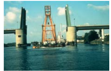
Ausbau der Klappen 1 und 2 der Herrenbrücke in Lübeck mittels Schwimmkran, Blick Richtung Nordwest.
