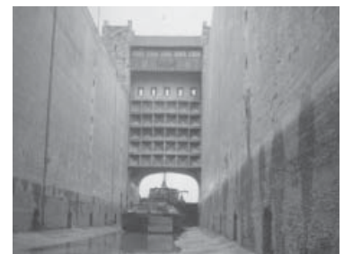
Alte Schachtschleuse Henrichsburg, trocken gelegte Kammer mit Schiff, Sicht auf Unterhaupt.
