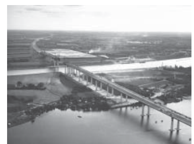
Autobahnbrücke über den Nord-Ostsee-Kanal bei Rade.
