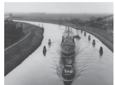
Ausgebaute Untere Hunte bei km 18, Schleppkahn schleppt Frachtschiff, Holz dalben.
