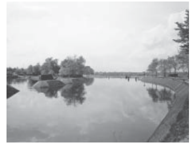
Charlottenburger Schleuse, Flutöffnungen am Trenndamm.
