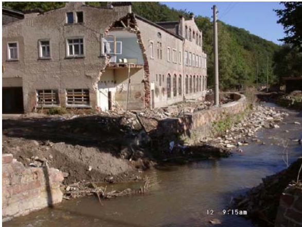
8 a) Schaden-Nr.:31-900008 und -900008 zerstörte Ufermauer und Gebäude im Bereich Filteretta
