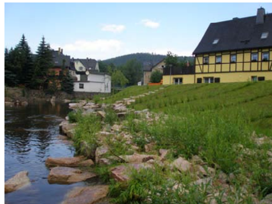
Abbildung 15: bereits erreichter Zustand Juni 2007, (vergleiche Abb. 6 vor Bau), Foto: Th. Müller, LTV
