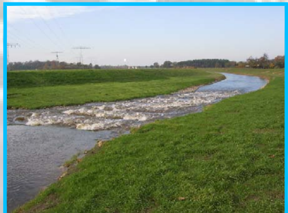
Schwarze Elster - Umbau Köhlerwehr
