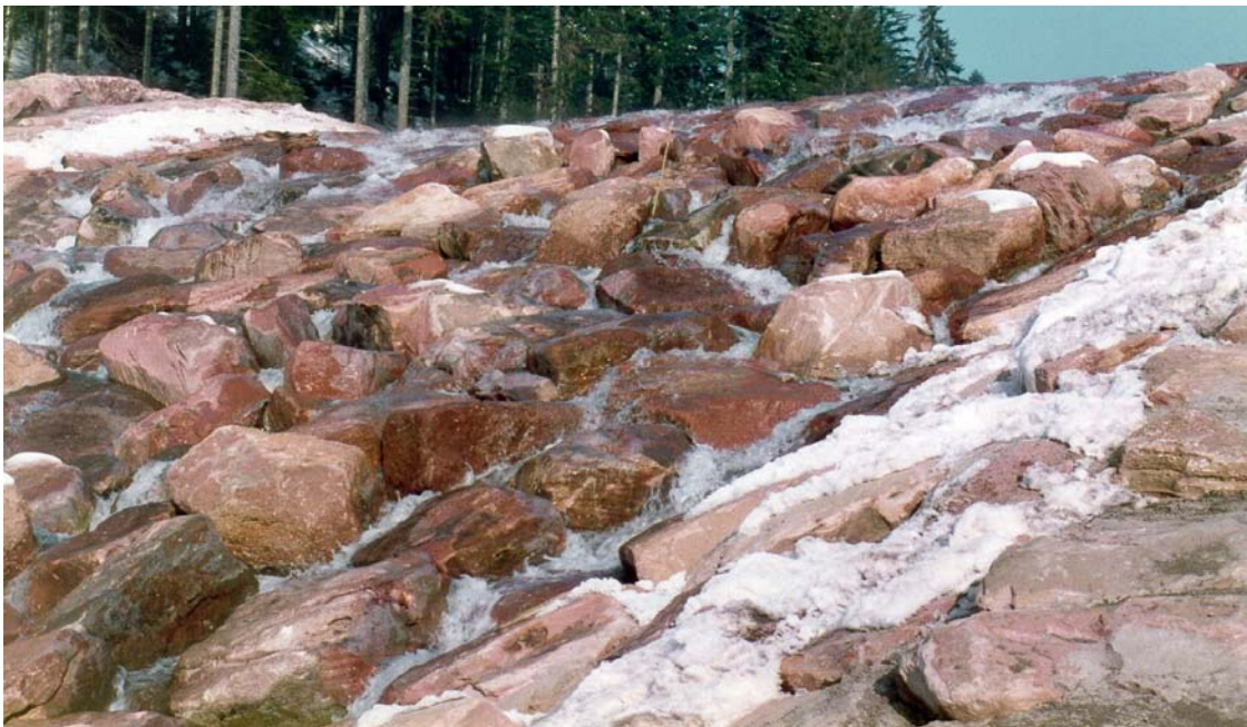
Abbildung 5: Detail Überlauf Dammkrone bei Mittelwasserführung
