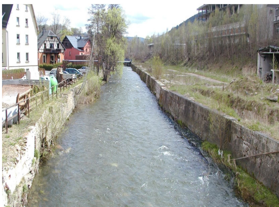
Abbildung 3: Zustand vor Baubeginn, Foto: A. Stowasser, Plan T
