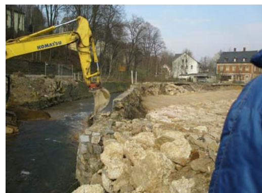
Abbildung 11: Durchstich zur Inbetriebnahme erstes Teilstück der neuen Gewässersohle, Foto: Th. Müller, LTV
