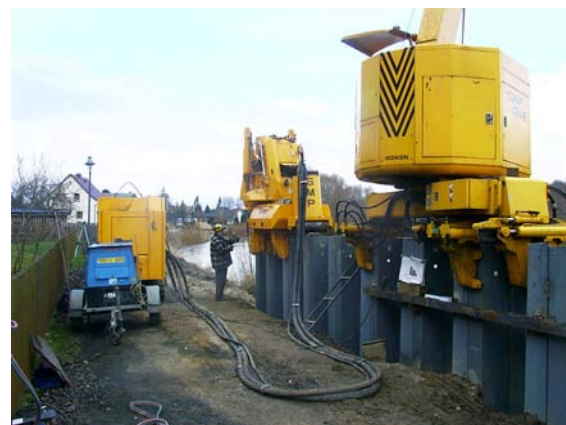
Abbildung 5: Einbausituation während der Bauphase
