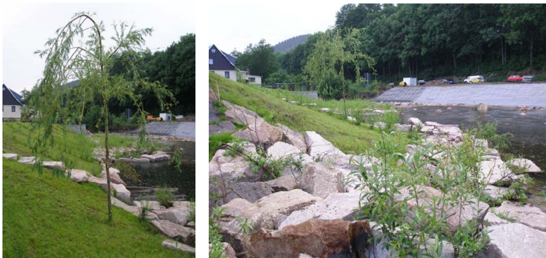
Abbildung 13: Verwallung, gezielte Ufervegetation, Fotos: Th. Müller, LTV
