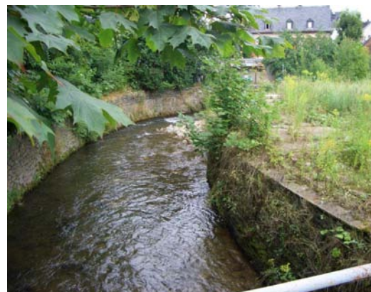
Abbildung 4: Zustand vor Baubeginn, Foto: Th. Müller, LTV
