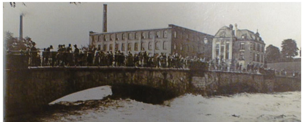
Abbildung 11: Hochwasser (31.7.1897) an der Zschopaubrücke in Mittweida (Stadtarchiv Mittweida)
