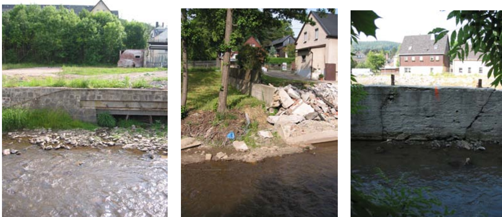
Abbildung 5: Zustand vor Baubeginn, Reste von Hochwasserschäden, Fotos: J. Ficker, Projekta
