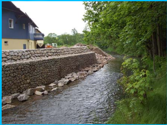
Hochwasserschutz "Große Striegis" Landkreis Mittweida: Ufersicherung
