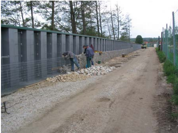
Abbildung 6: Spundwandabschnitt mit Gabionenverkleidung (Bauzustand)
