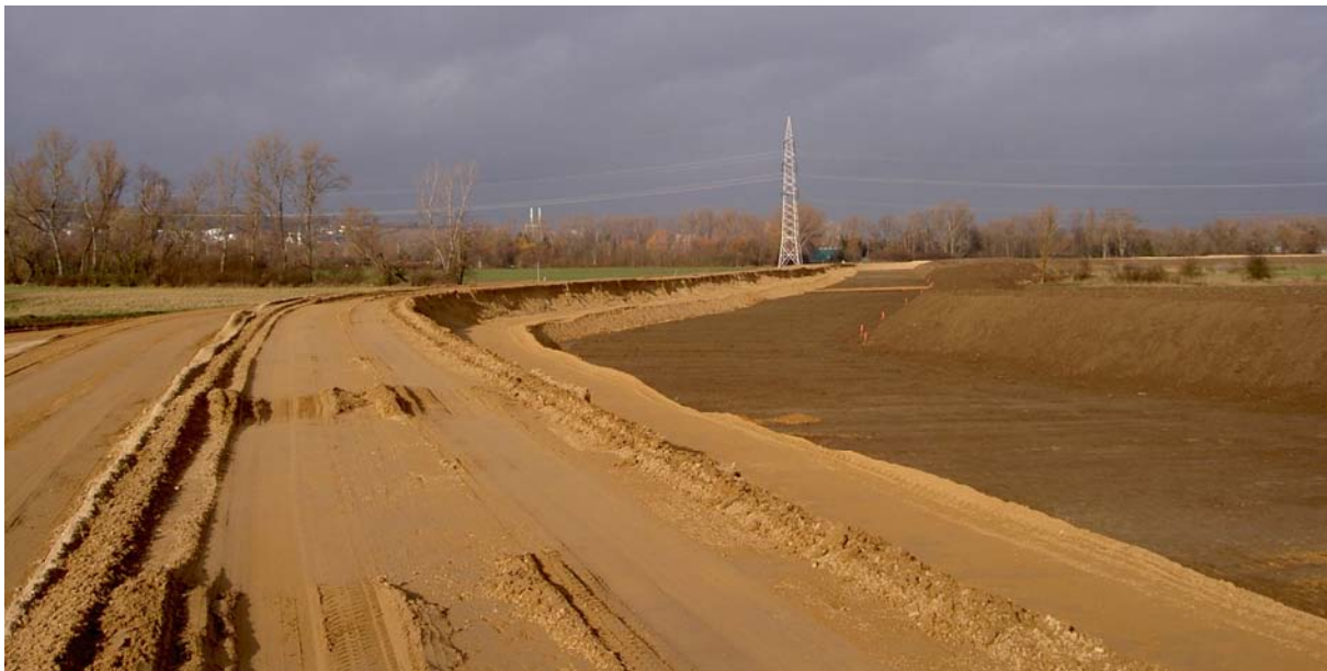
Abbildung 3: Neubau des Deichs mit Untergrundabdichtung (Foto SGD Süd )
