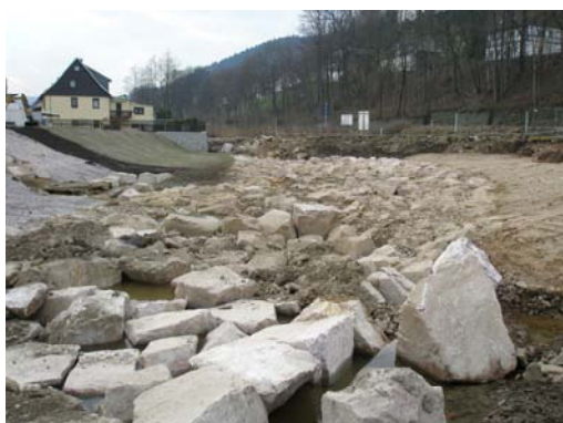
Abbildung 10: Neue Sohlbefestigung Foto: Th. Müller, LTV
