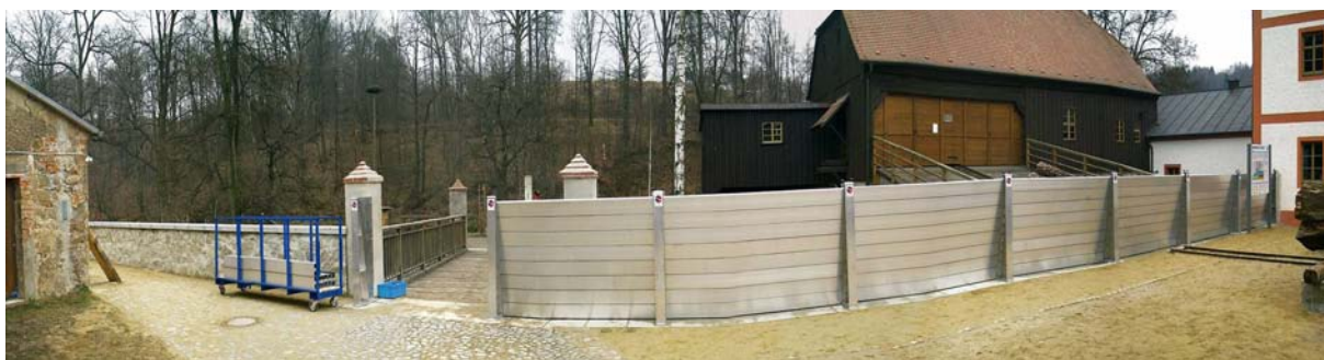
Abbildung 3: Aufbau mobiler Hochwasserschutz im Kloster St. Marienthal
