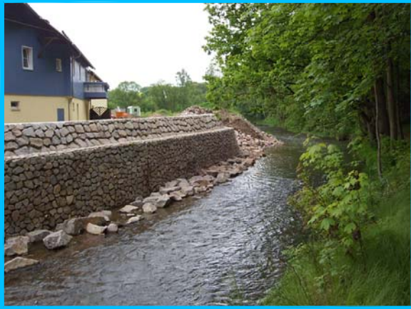
Hochwasserschutz "Große Striegis" Landkreis Mittweida: Ufersicherung
