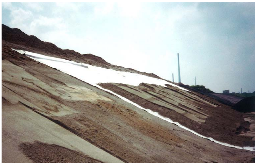
Abbildung 2: Bentonitmatte auf Brechsandschicht und mit teilweiser Überdeckung
