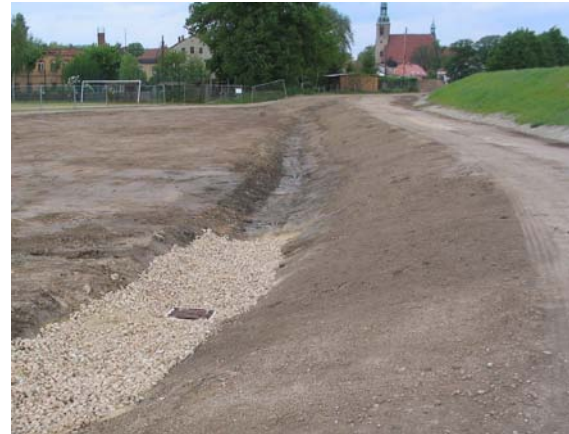
Abbildung 7: Bauzustand Deich BA2, Verteidigungsweg, luftseitige Drainage)
