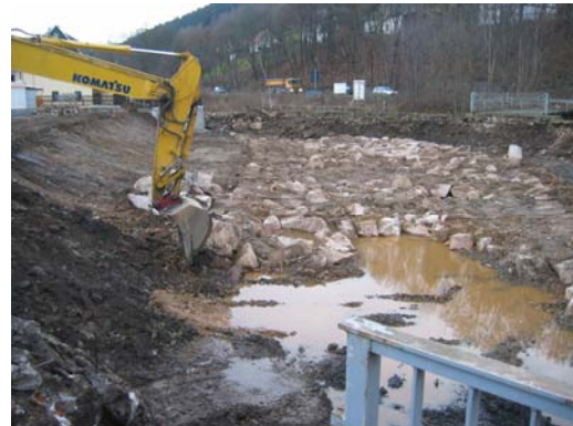
Abbildung 7: Sohl- u. Uferprofilierung Foto: Th. Müller, LTV
