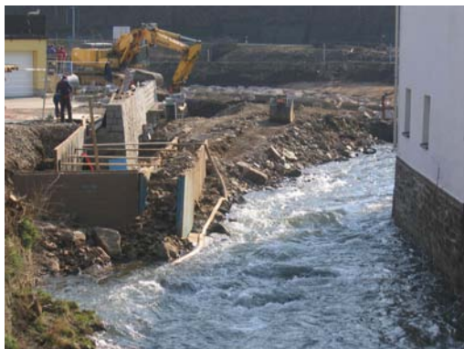
Abbildung 8: Anlegen der HWS-Mauer Foto: Th. Müller, LTV
