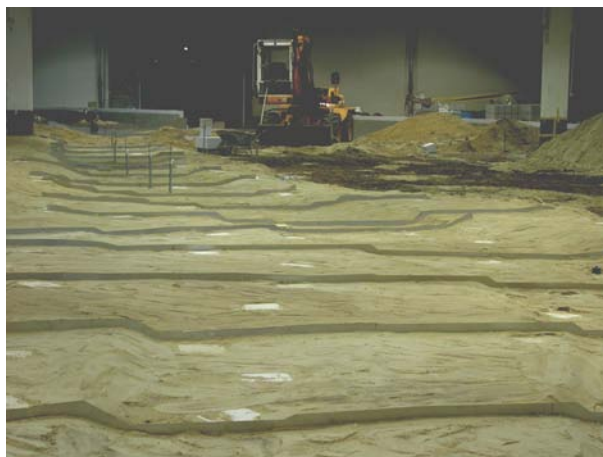
Abbildung 3: Einbau der Edelstahlschablonen zur exakten Geländenachbildung
