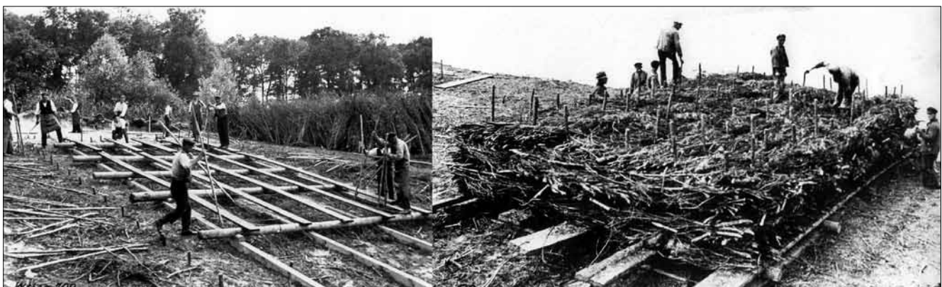
Bild 10: Arbeitsprozess der Sinkstückvorfertigung an Land Figure 10: Pre-fabrication of the fascine mats on land
