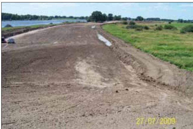
Bild 7: Deichschlitz Nr. 1 nach Fertigstellung der Erdarbeiten
