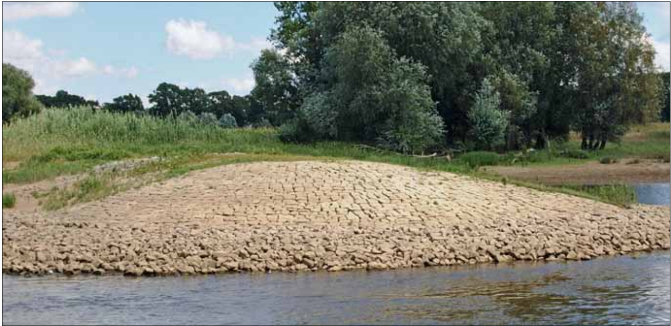
Bild 9: Die historische Faschinensinkstück- und Packwerksbauweise Figure 9: Ballasted fascine mat and revetment methods formerly uses
