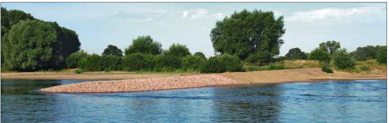
Bild 15: Buhne nach Grundinstandsetzung in Schüttbauweise Figure 15: Concrete groyne following major repair
