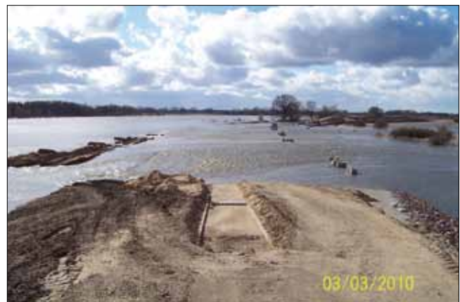
Bild 8: Überströmung des Deichschlitzes Nr. 1, Blick nach Unterstrom, links: Elbe, rechts: neue Überschwemmungsfläche
