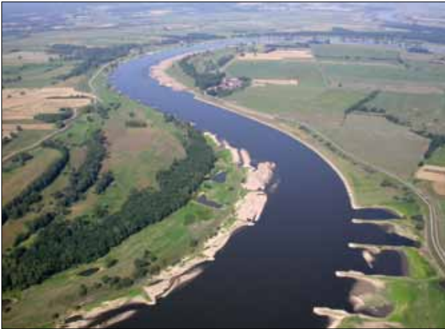
Bild 10: Elbe bei Müggendorf (El-km 464) (Foto Meier (Rana) im Auftrag der BfG, 2003)
