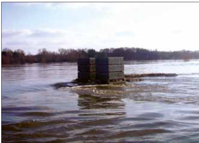
Bild 4: Abgestellte Pflastersteinpalette im Schlitzprofil 1 am 8. März 2010
