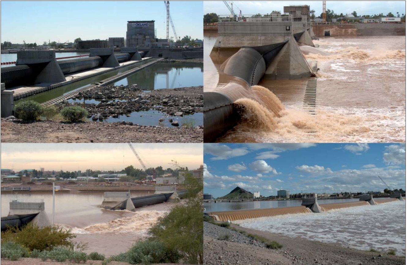
Bild 15: Tempe Town Lake: oben links) Verschlüsse in Staustellung, oben rechts) Absenkbeginn, unten links) vollständig abgelegter Schlauchverschluss beim Hochwasser, unten rechts) Wehranlage in Betrieb
