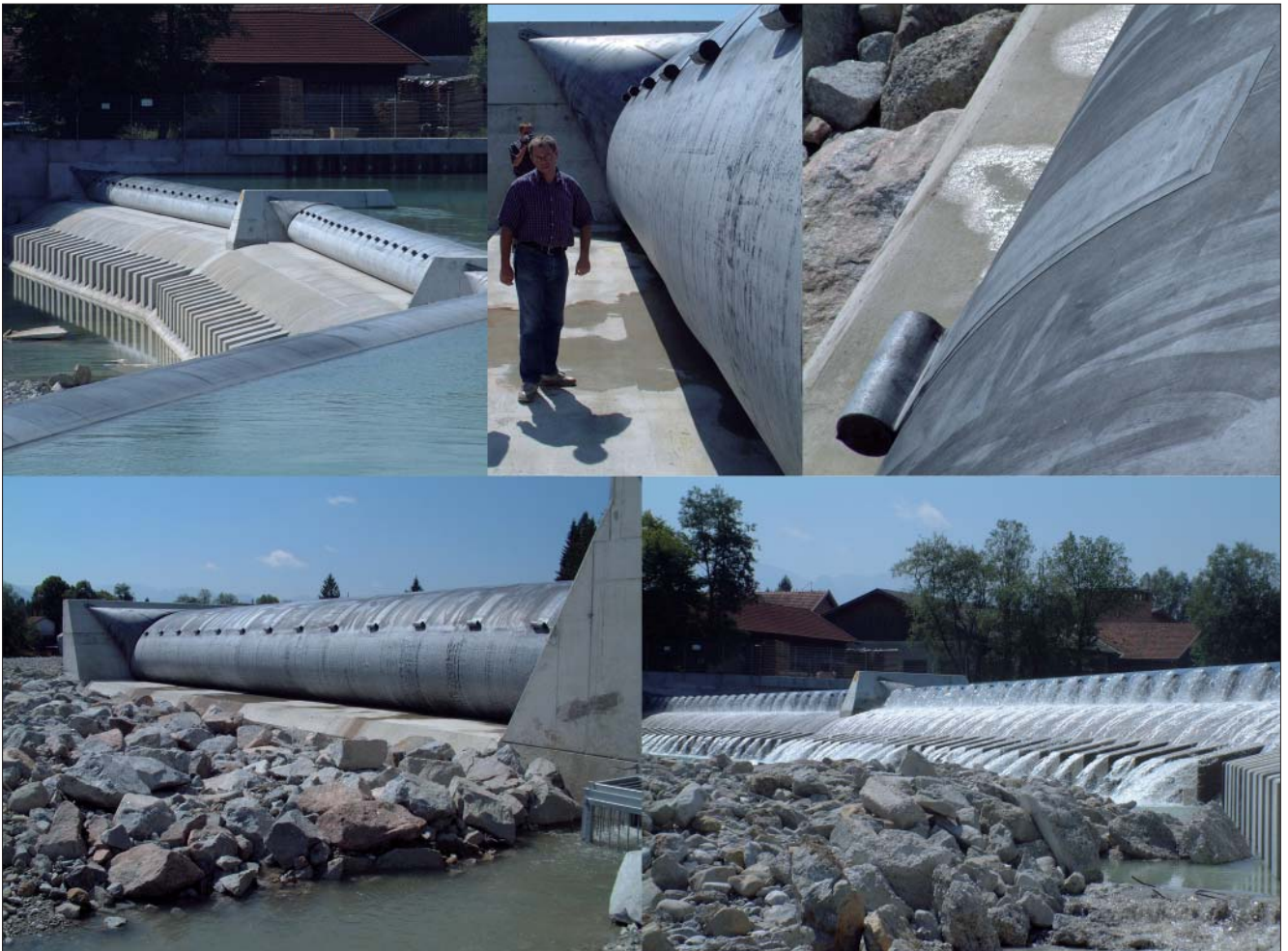
Bild 10: Schlauchwehr Lechbruck am Lech: oben links) Blick auf die 1,35 m hohen Schlauchkörper, oben Mitte) Hauptverschluss mit einer Höhe von 3,35 m, oben rechts) Störkörper, unten links) Hauptverschluss mit Entleerung, unten rechts) überströmte Verschlüsse
