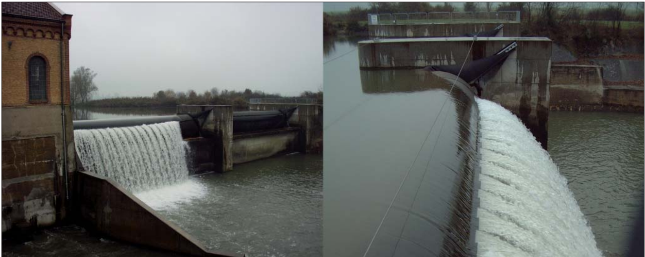
Bild 7: Schlauchwehr Kiebingen am Neckar: links) Krafthaus mit Wehranlage, rechts) Blick vom rechten Ufer
