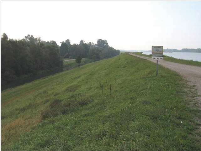
Bild 5: Stauhaltungsdamm oberhalb der Staustufe Iffezheim
