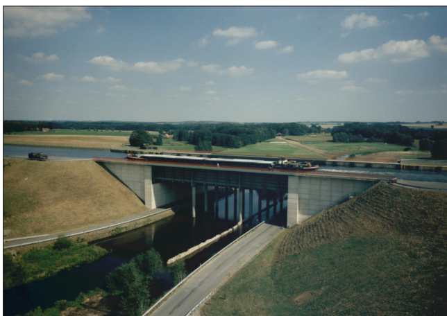
Bild 2: Kanalbrücke des ESK (Quelle: WSA Ülzen) Figure 2: Water-channel bridge of the ESK (source: WSA Ülzen)
