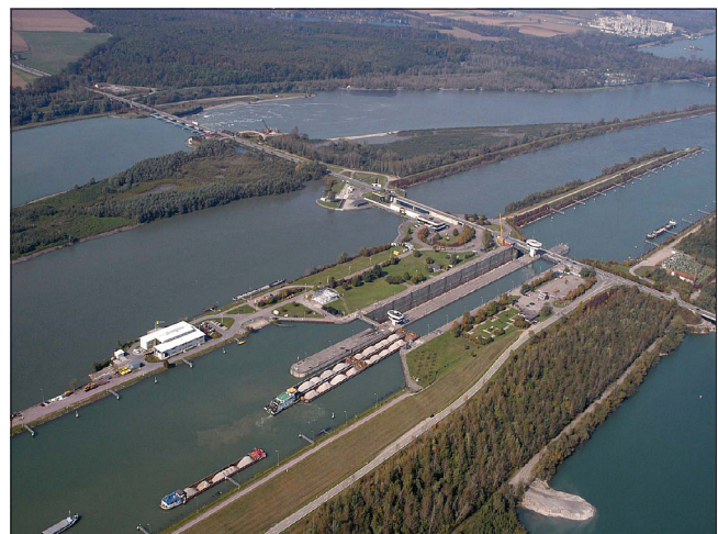
Bild 4: Staustufe Iffezheim am Oberrhein Figure 4: Iffezheim barrage on the Upper River Rhine
