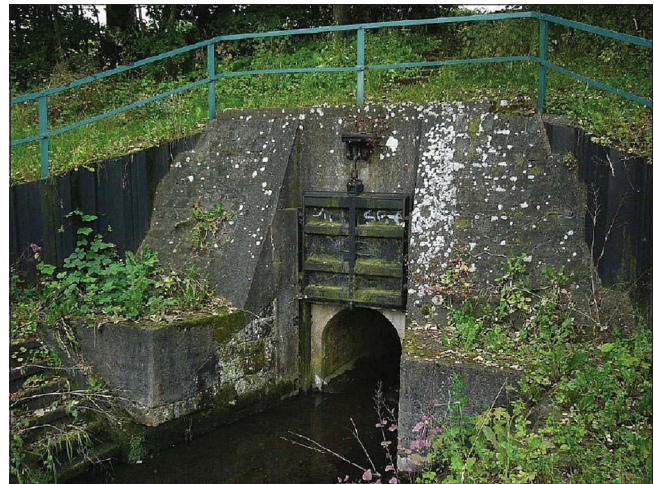
Bild 3: Düker am MLK Figure 3: Culvert below the MLK
