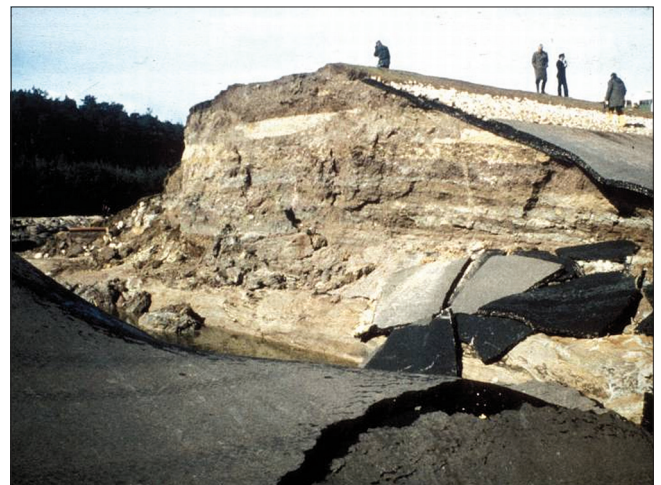
Bild 12: Dambruchstelle am MDK (Quelle: Gutachten zur Schadensursache)
