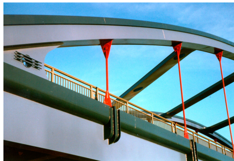
Bild 4: Farbgestaltung und Hängeranschlüsse, „Harfe“ am Übergang Bogen-Längsträger
