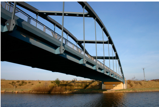
Bild 5: Querträger nach außen geführt
