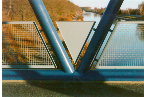
Bild 17: Geländerausbildung der Fachwerkbrücke in Wolfsburg
