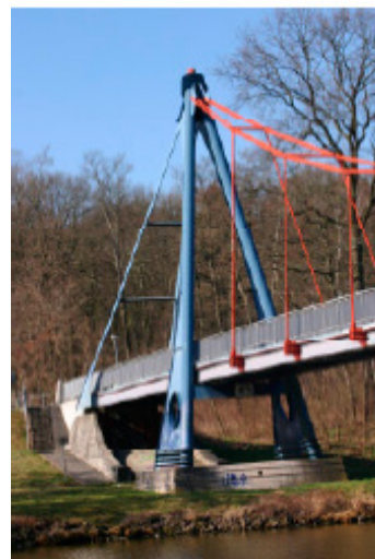
Bild 21: Pylon der „Flora“-Brücke
