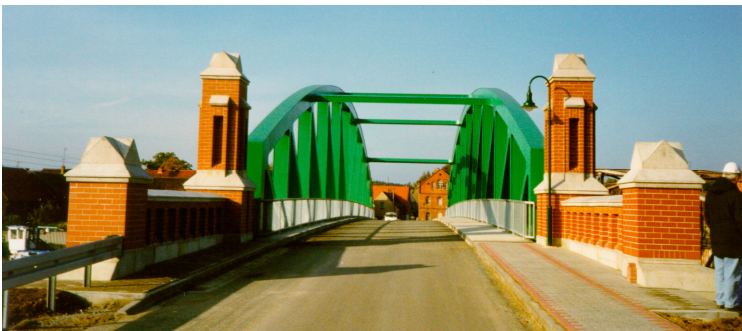
Bild 18: Fachwerkbrücke in Bülstringen
