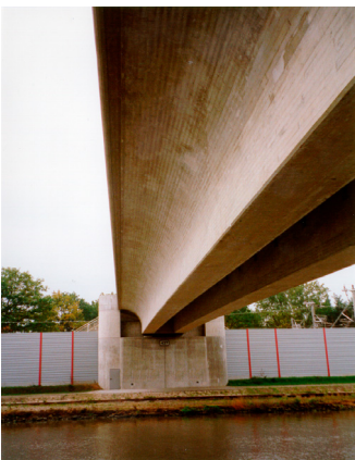
Bild 14: Spannbetonbrücke in Wolfsburg mit konkaver Wölbung
