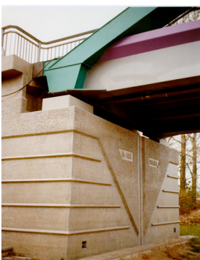
Bild 7: Widerlager einer „V“-Brücke
