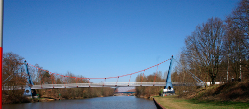
Bild 19: Fußgängerbrücke „Flora“ in Haldensleben
