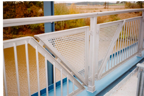
Bild 6: Dreieckiges Geländerelement im Bereich der Hänger
