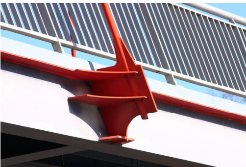
Bild 20: Fußgängerbrücke in Haldensleben, Anschluss an die Längsträger
