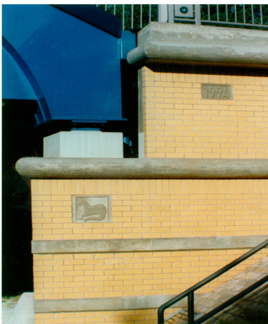
Bild 3: Widerlager einer „Drömling“-Brücke
