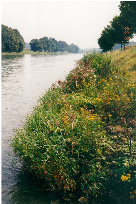
DEK Senden, verklammertes Deckwerk, 25 Jahre ohne Unterhalt
