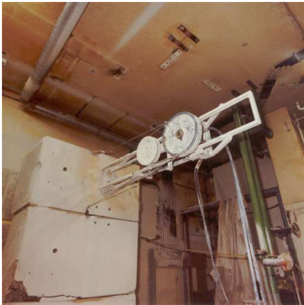
Abb. 2.13: Seilsäge im Einsatz im AKW Grundremmingen [Quelle: Werkfoto Grundremmingen] 6
