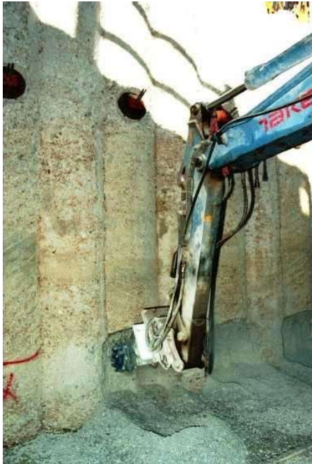
Abb. 2.17: Querschneidkopf beim Herausfräsen von Teilen eines Bohrpfahls
