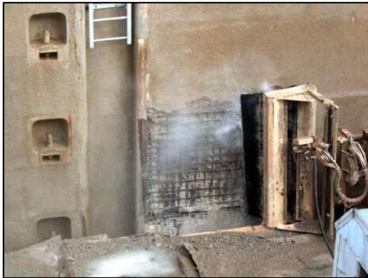
**Abb. 22: HDW-Robotereinheit im Einsatz**
