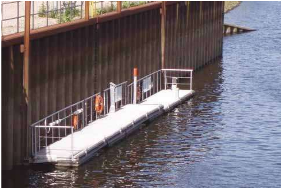
Abb. 14 Schwimmsteg mit unterschiedlichem Freibord (RiGeW, Anhang 4, Bild 17)
