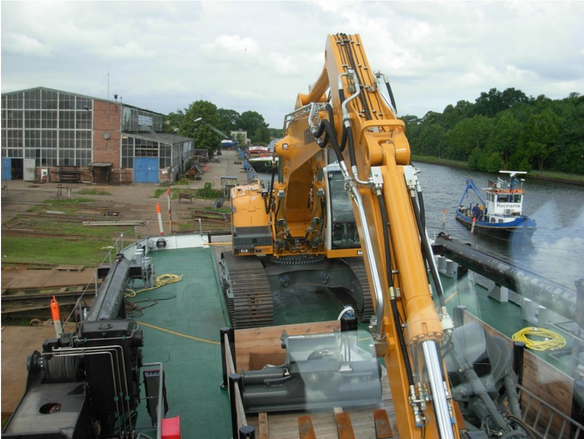
Abbildung 3: SG Stove Sicht aus Steuerhaus auf Arbeitsdeck
