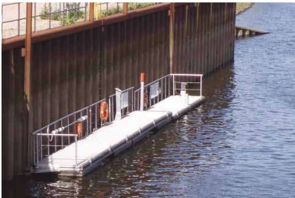
Abb. 14 Schwimmsteg mit unterschiedlichem Freibord (RiGeW, Anhang 4, Bild 17)
