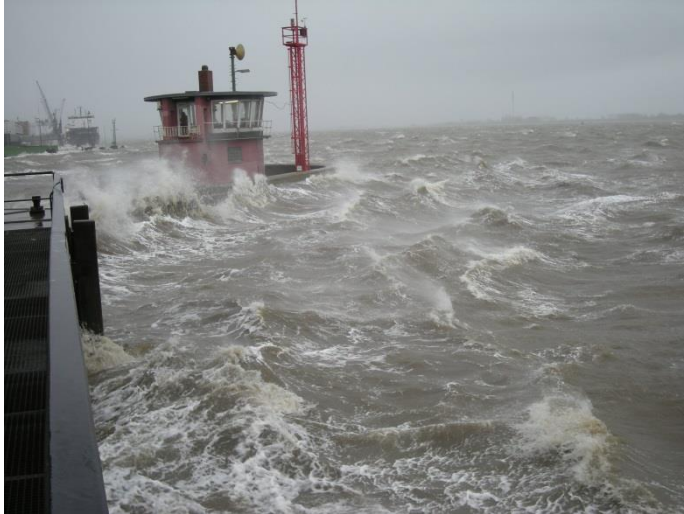
Nordschleuse im Sturm 09.11.2007
