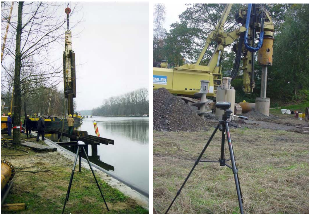
Abbildung 18: Messung der mit dem Baumaschineneinsatz verbundenen Schallemission - Hydraulikkranne (links) und Großloch-Bohrgerät (rechts)
