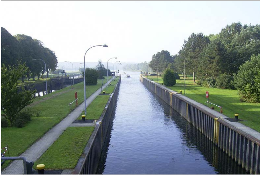
Schleusengruppe bei Hilter am DEK bei km 186 (Quelle: BfG)
