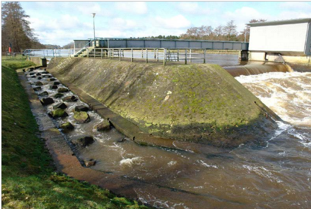
Fischaufstiegsanlage der Schleuse „Bollinger Fähr“ an der Ems bei Heede (Quelle: BfG)
