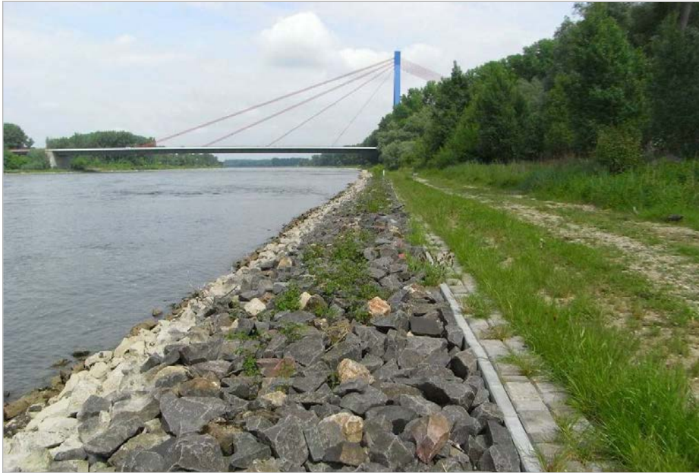
Vegetationsarme Schüttstein-Ufersicherung am Rhein, ca. km 403 (Quelle: BfG)
